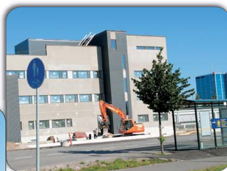
Finavian lentoaseman tekniikan kunnossapitorakennus.
