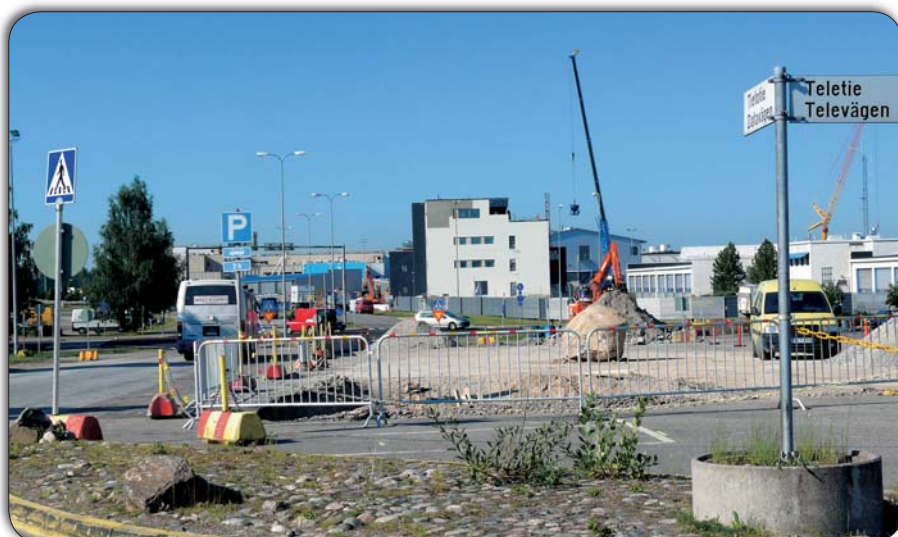
World Trade Center -rakennuksen rakennustyöt alkavat 2007.
