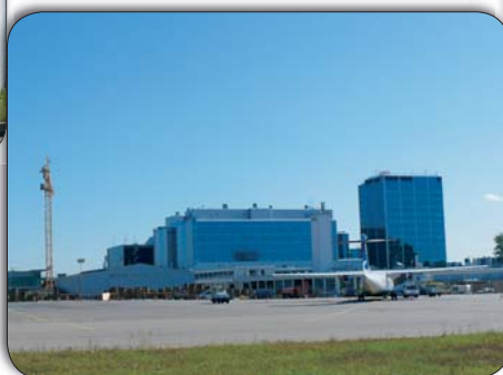
Ulkomaanterminaali laajennusosan rakennustyöt ovat alkaneet. Käyttöön laajennusosa tulee syksyllä 2009.
