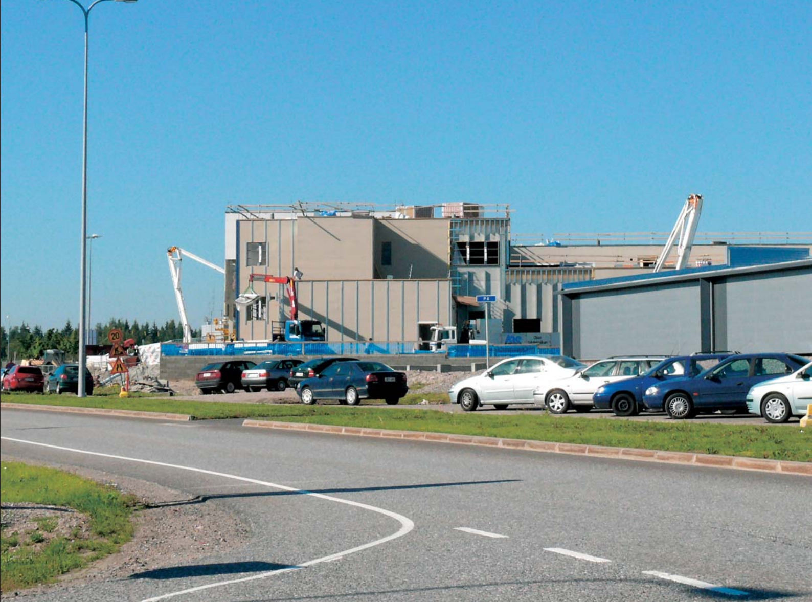
Finnair Catering Oy:n uudisrakennus otetaan käyttöön keväällä 2008.
